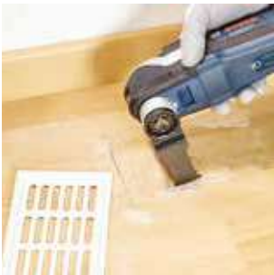
穿刺切割層壓板， 例如：安裝通風格柵
