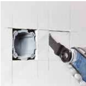
簡單穿刺切割石膏板
